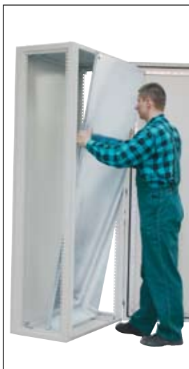
Sposób montażu płyty montażowej w szafie
